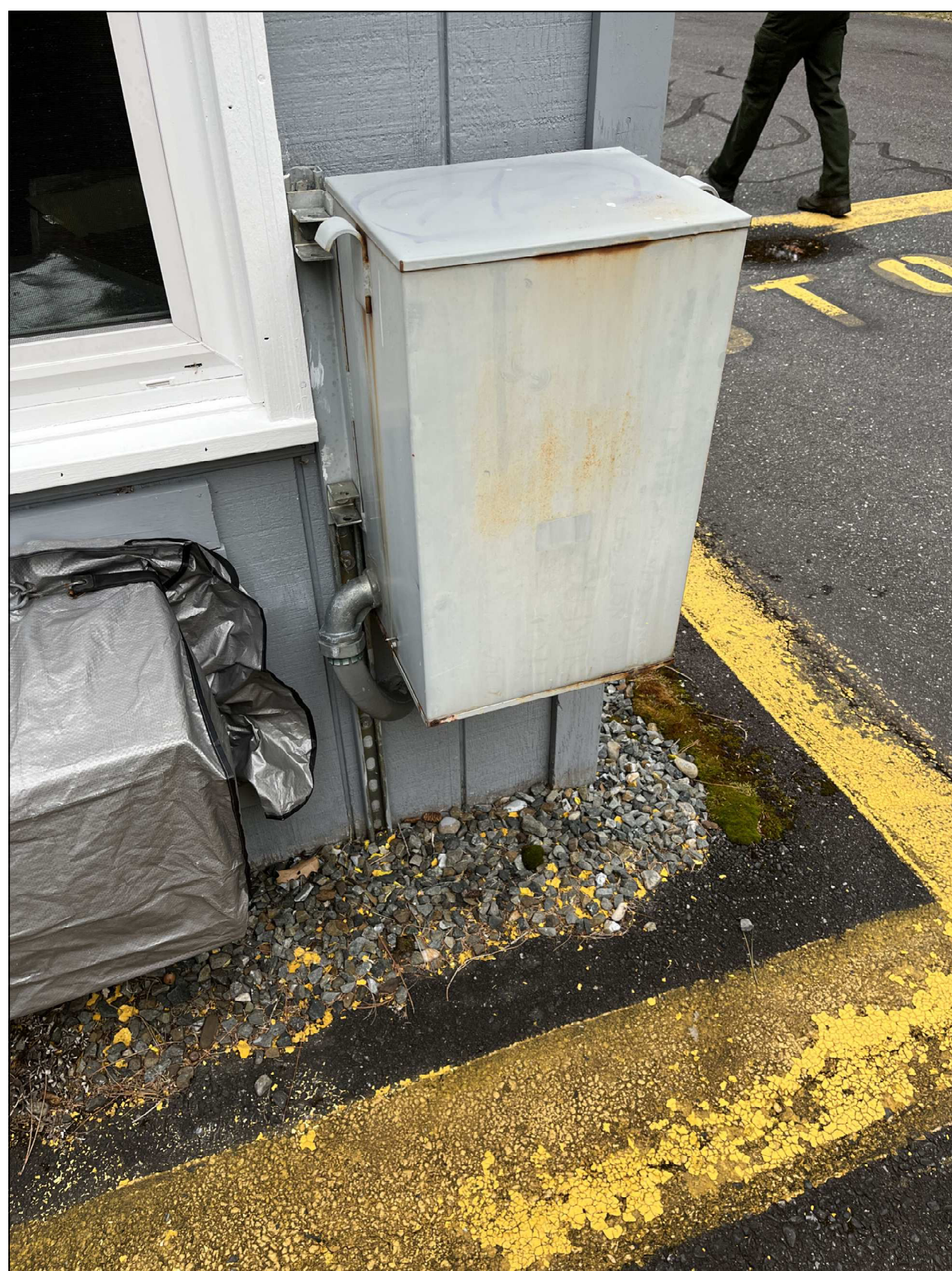
EXISTING 10kVA TRANSFORMER (GUARD BOOTH) A8 SCALE: N.T.S
